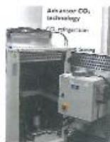
Advansor-Kältesatz mit R744 für eine kleine Leistung für Außenaufstellung
