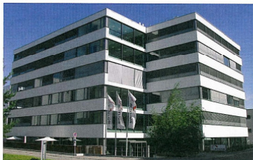
Der erste Feldversuch von „OptiControl“ findet an einem fünf Jahre alten Bürogebäude des Pharmaunternehmens Actelion in Allschwil bei Basel statt. Seit Herbst 2011 werden 18 Monate lang neue Regelalgorithmen getestet und der Betrieb überwacht. (Abb. Actelion)
