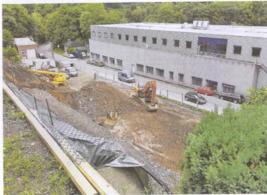
4000 Kubikmeter Erde wurde abgebaggert und fortgefahren. Wurm baut ein Büro- und Lagergebäude an der Morsbachtalstraße. Foto: Michael Sieber
